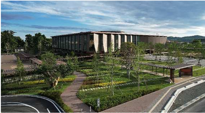
石川県立図書館 カラー舗装
