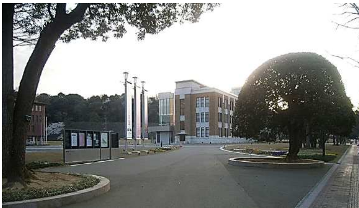
しいのき迎賓館 自然色舗装
