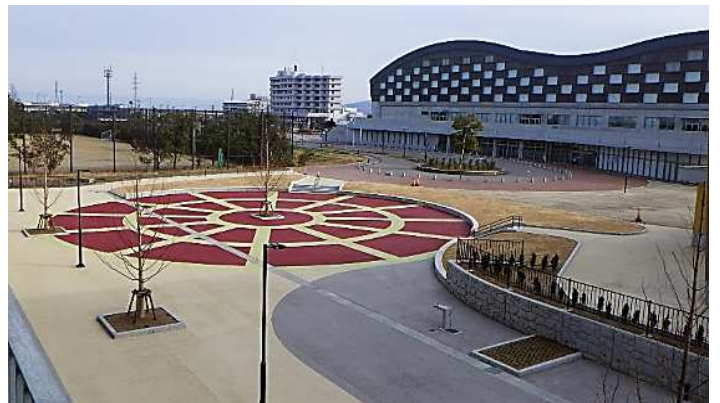
金沢サッカースタジアム 薄層カラー舗装（EGコート）
