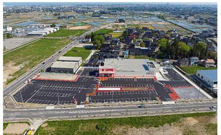
野々市市内商業施設 駐車場
