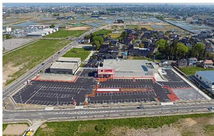
野々市市内商業施設 駐車場
