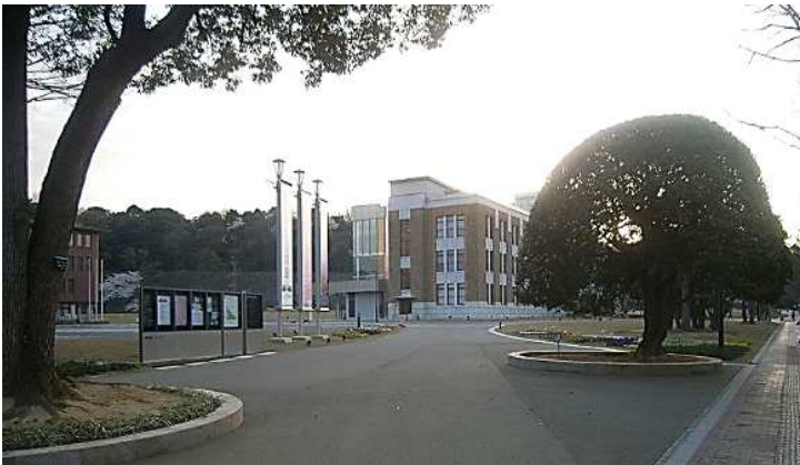
しいのき迎賓館 自然色舗装
