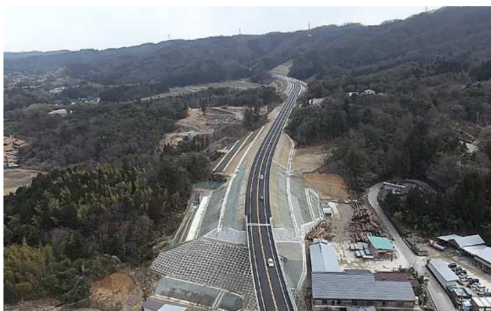
能越自動車道 自動車専用道路
