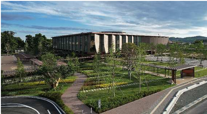
石川県立図書館 カラー舗装
